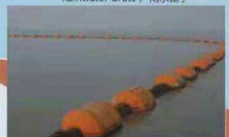
Dredging pipe at sea / 海上清淤管
